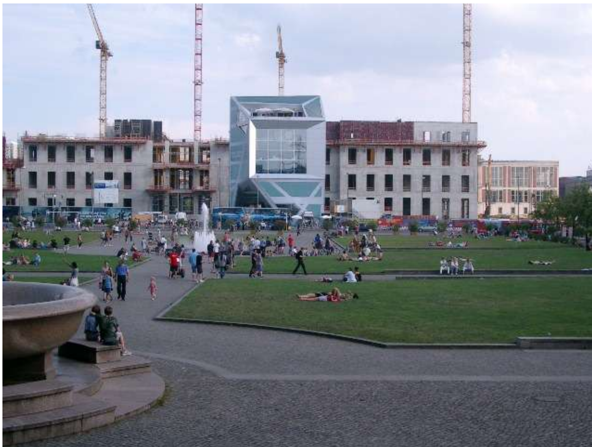
La Schloßplatz con i lavori per la ricostruzione del Castello. Al centro la struttura provvisoria della Humboldt Box come punto informativo sul cantiere realizzata dalla studio KSV in opera dal 2011 al 2019
